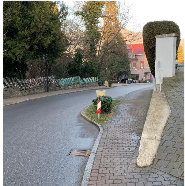
Abbildung 36: Einengung Gehweg Ernst-Eisenlohr-Straße
