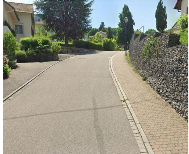
Abbildung 30: Oberer Kirchweg einseitiger Gehweg (Google Earth)
