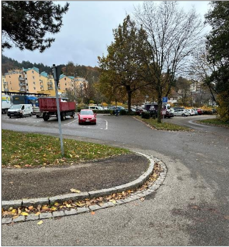
Abbildung 71: Fehlende Bordsteinabsenkung Ernst-Eisenlohr-Straße
