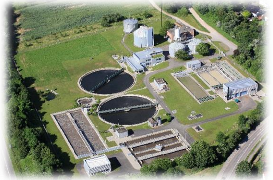
Verbandskläranlage Neuenburg am Rhein Kreuzgrundweg 1, 79395 Neuenburg am Rhein
